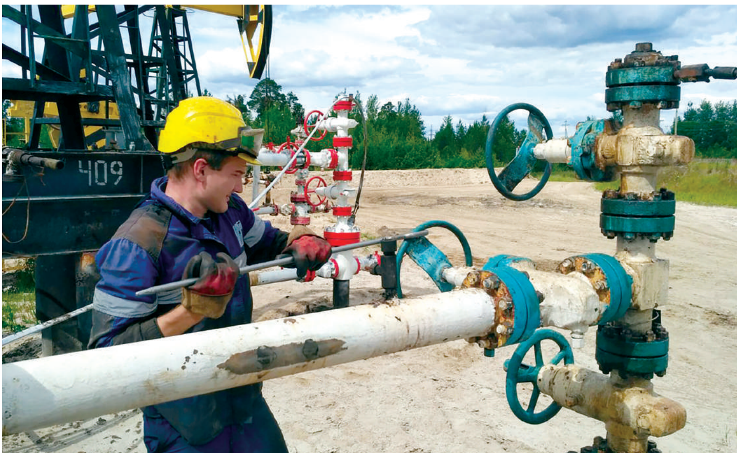
Николай Круглов проводит демонтаж арматурной фонтанной установки по поддержанию пластового давления скважины
