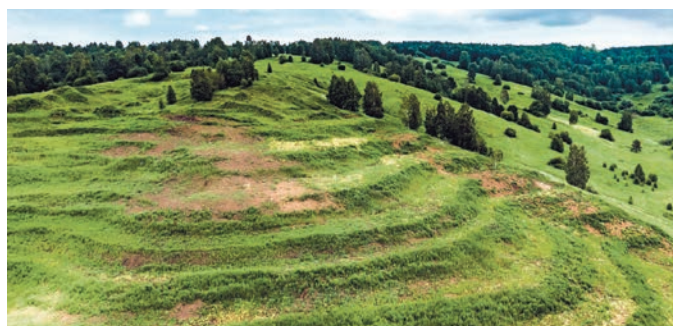
Террасы горного отвода шахты, рекультивированного с помощью золошлаковых материалов
