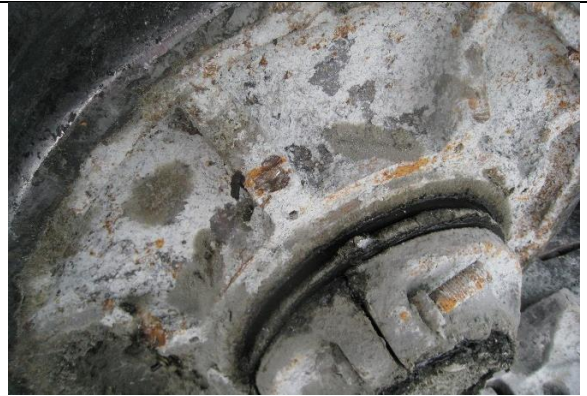
Комментарий: ослабление крепления хомутов опорных колёс (зазоры от 15 до 25 мм)
