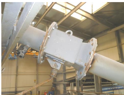
Рисунок 7.7 – Расположение щелевых пробоотборников ПЩП-159-02К и ПЩП-219-04К на вертикальных участках трубопроводов: а – пробоотборники щелевые ПЩП-159-02К; б – пробоотборник щелевой ПЩП-219-04К в составе СОП-1-219-04П
