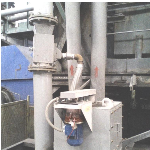
Рисунок 7.7 – Расположение щелевых пробоотборников ПЩП-159-02К и ПЩП-219-04К на вертикальных участках трубопроводов: а – пробоотборники щелевые ПЩП-159-02К; б – пробоотборник щелевой ПЩП-219-04К в составе СОП-1-219-04П
