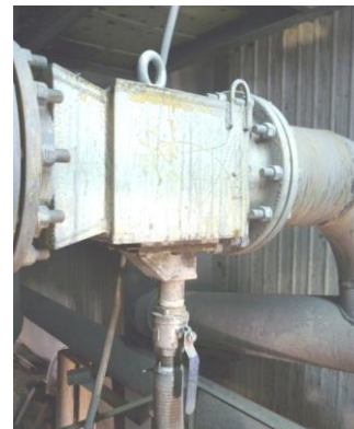
Рисунок 7.7 – Расположение щелевых пробоотборников ПЩП-159-02К и ПЩП-219-04К на вертикальных участках трубопроводов: а – пробоотборники щелевые ПЩП-159-02К; б – пробоотборник щелевой ПЩП-219-04К в составе СОП-1-219-04П
