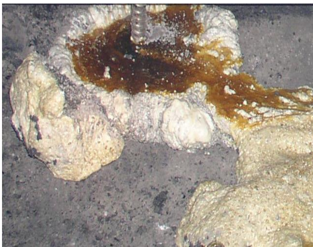
Рис. 1. Полиуретановая смола Беведол – Беведан: а – виде покрытия; б – закрепления массива
