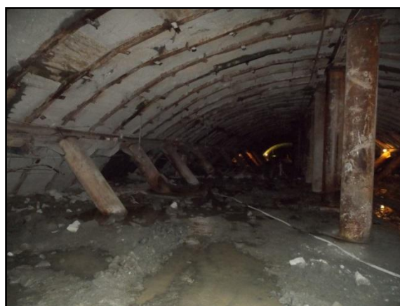
Рисунок 1 – Подпорная крепь калотты станции «Торговый центр»
