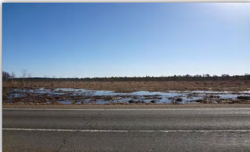
Рисунок 2 – Заболачивание территории вдоль дороги
