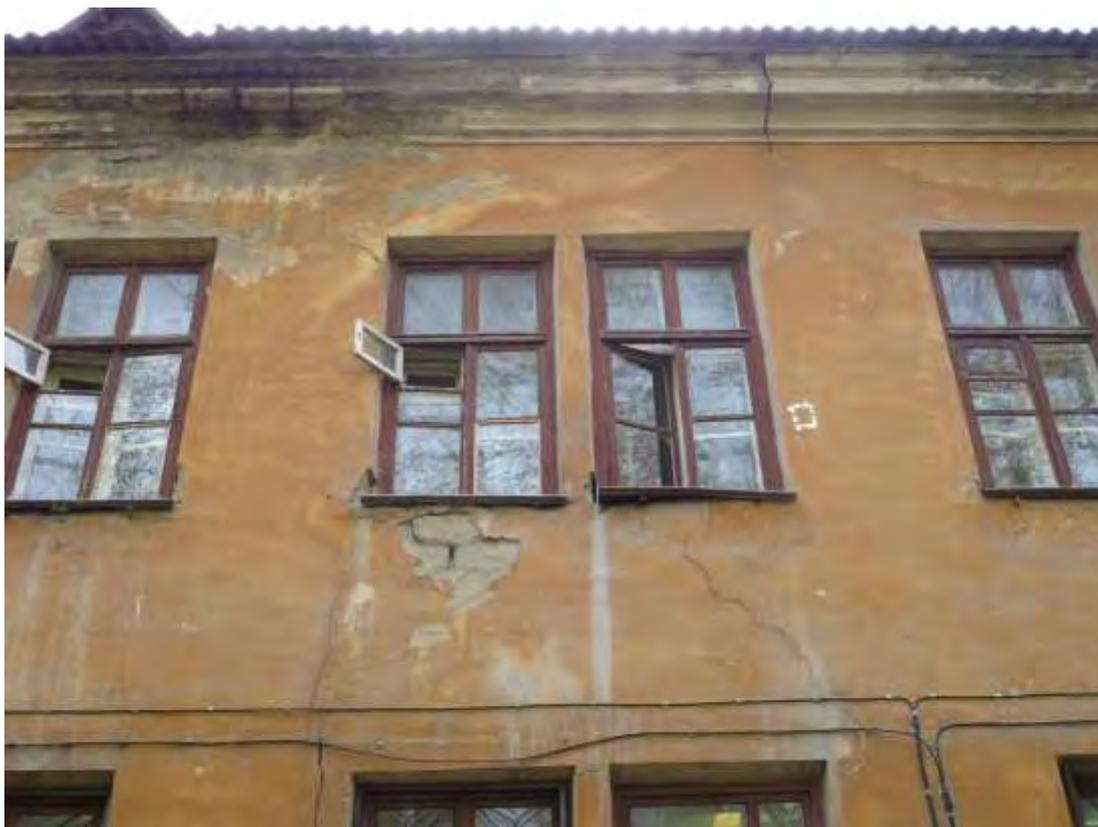
**Рис. 2. Трещины в подрабатываемом сооружении**
