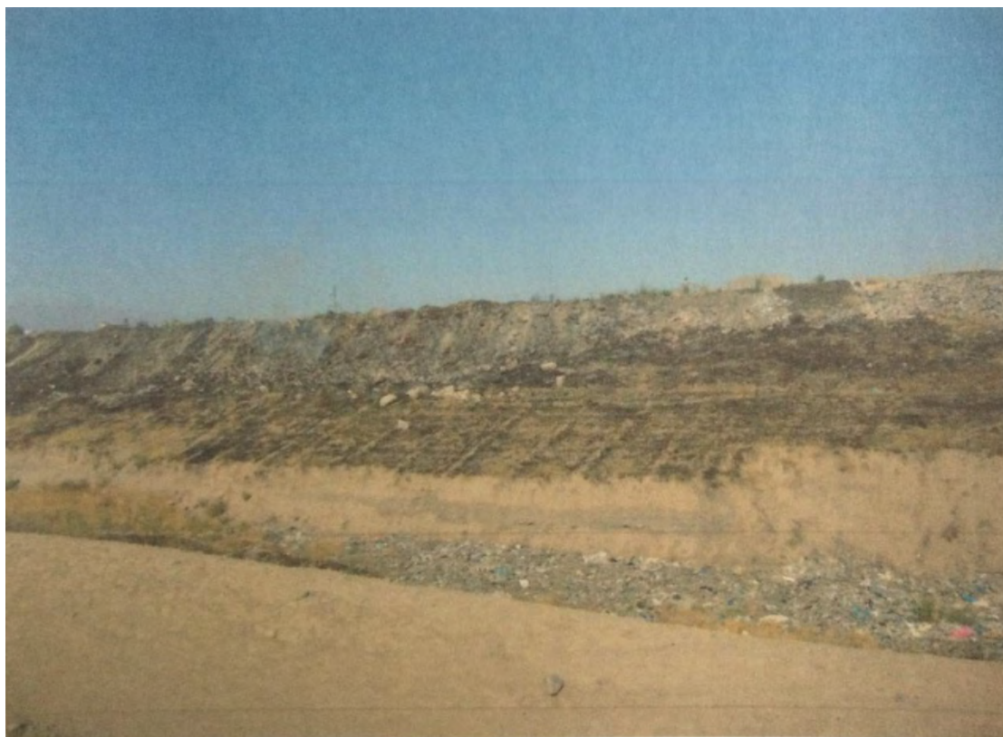
Рис. 1. Вид на дамбу хвостохранилища КГРК и свалку твердых отходов (северо-западная часть хвостохранилища)
