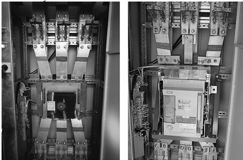
Рис. 2. Пример ретрофитного решения в НКУ: а - вид старого оборудования; б – вид нового оборудования
