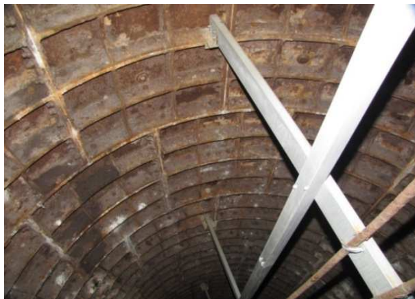
Рис. 1. Общий вид чугунной тубинговой обделки ствола шахтной вентиляции
