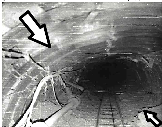
Рис. 2. Потеря выработкой устойчивости по второй схеме
