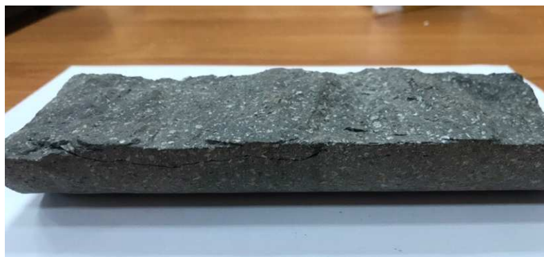
Рис. 1. – Образец поверхности трещины
