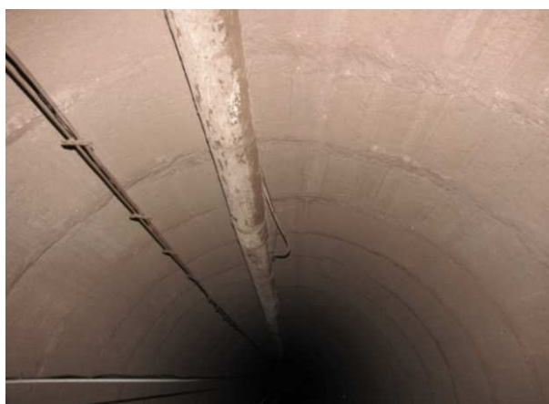
Рис. 3. Общий вид монолитной железобетонной обделки ствола шахтной вентиляции
