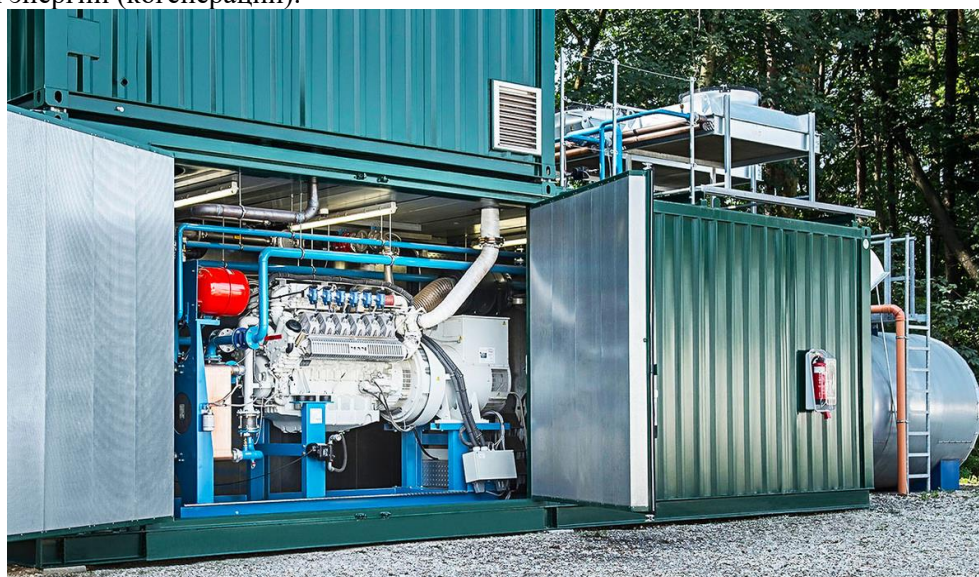
Рисунок 1 - Когенерационная установка (Мини ТЭЦ)
