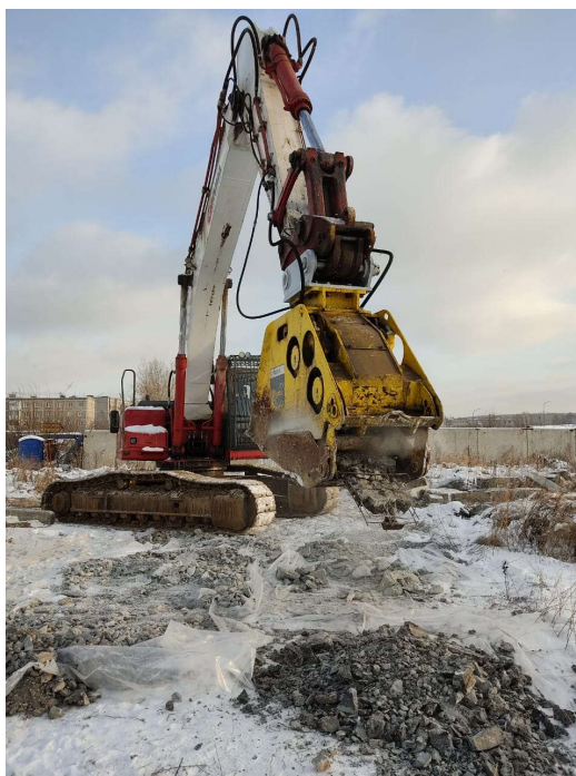
Рисунок 1 – Получение вторичного щебня с помощью дробильного ковша
