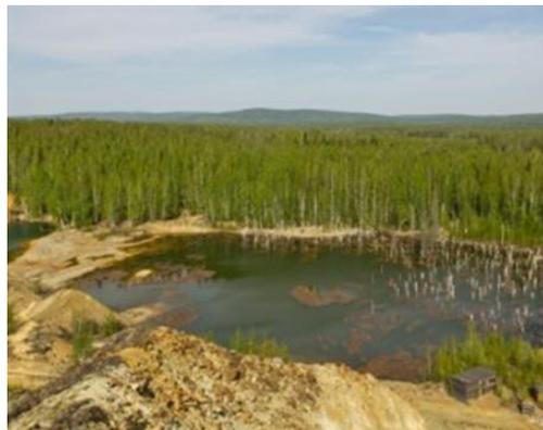
**Рисунок 12 – Ломовский рудник. Затопленный провал над зоной обрушения (п. Ломовский, Свердловская область)**
