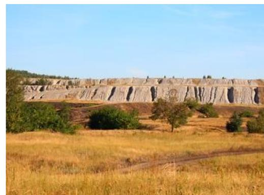
**Рисунок 8. Коркинский разрез. Видны эродированные склоны отвалов горных пород (г. Коркино, Челябинская область)**
