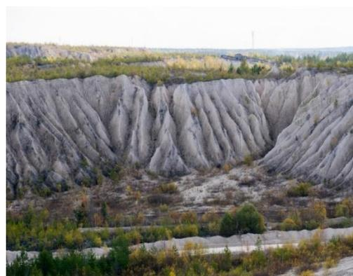
**Рисунок 2 - Отработанный карьер. Видна водная эрозия бортов.**
