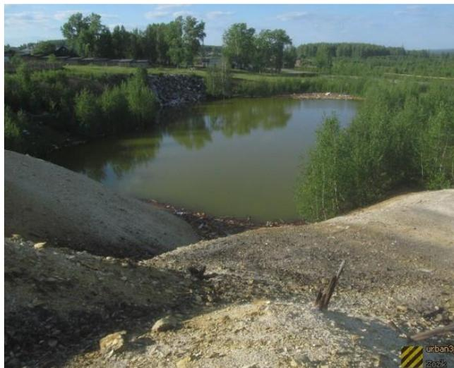
**Рисунок 3 - Затопленный провал на медном руднике, п. Карпушиха (Свердловская область)**
