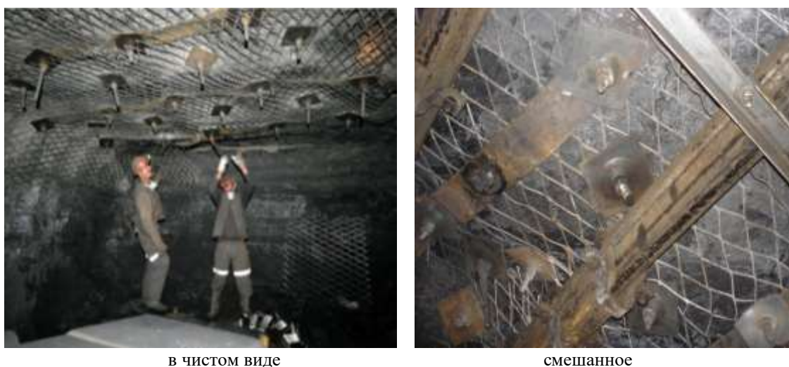
Рис. 2 - Анкерное крепление горных выработок
