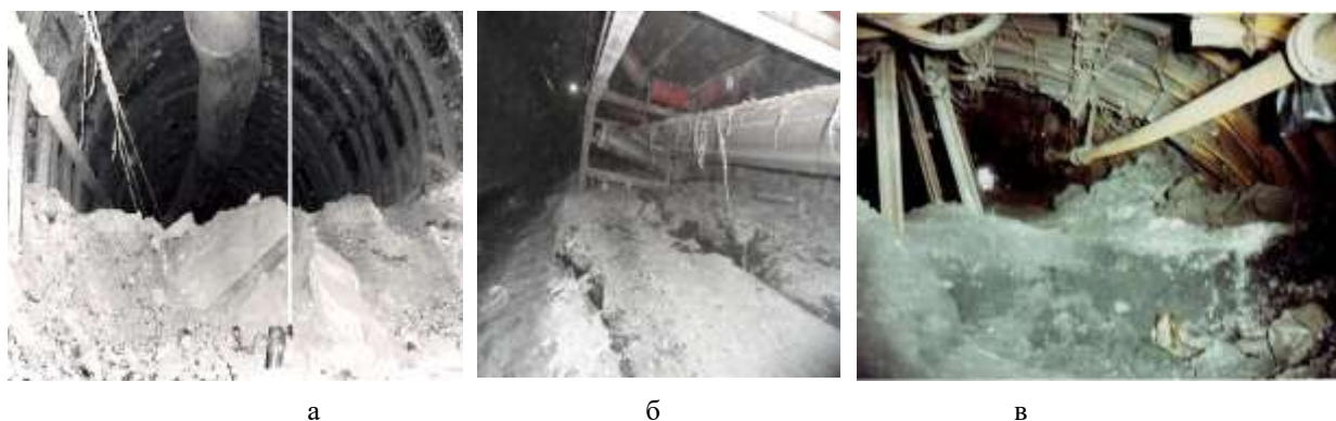
Рис.4–Деформации выработок по середине почвы (а), по бокам (б), контуров (в) выработок
